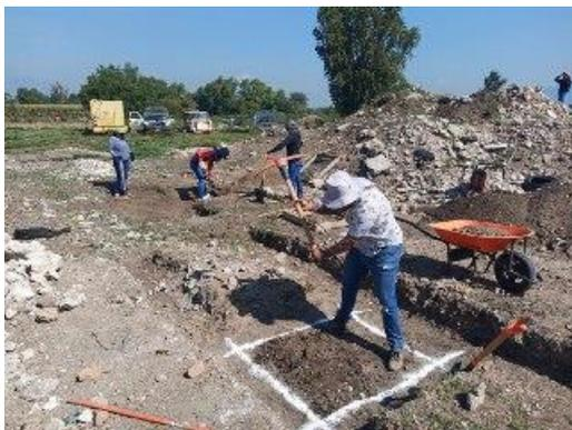
Imagen 30: Excavación de pozo de desechos para letrina.
