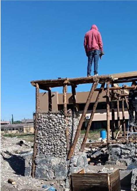
Imagen 63: Estructura para tinaco. Fuente: Elaboración propia.
