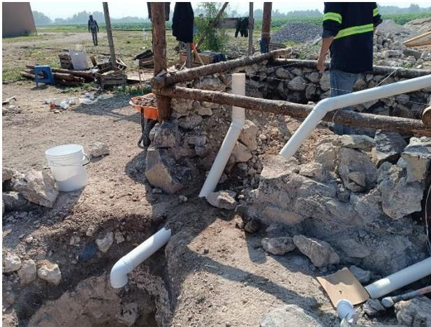
Imagen 37: Instalación de tubería sanitaria. Fuente: Elaboración propia.
