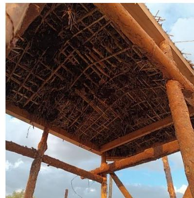
Imagen 49: Cubierta para módulo de baños. Fuente: Elaboración propia.
