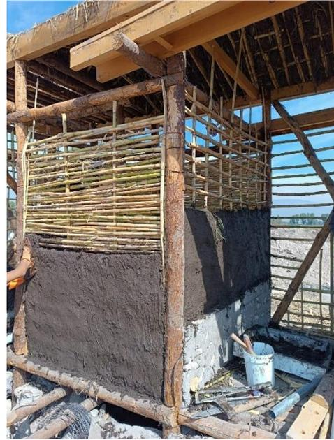
Imagen 46: Elaboración de muros de bahareque para baño seco y letrina. Fuente: Elaboración propia.
