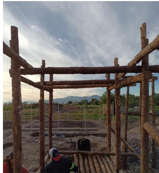
Imagen 44: Colocación de traves para baño seco y letrina. Fuente: Elaboración propia
