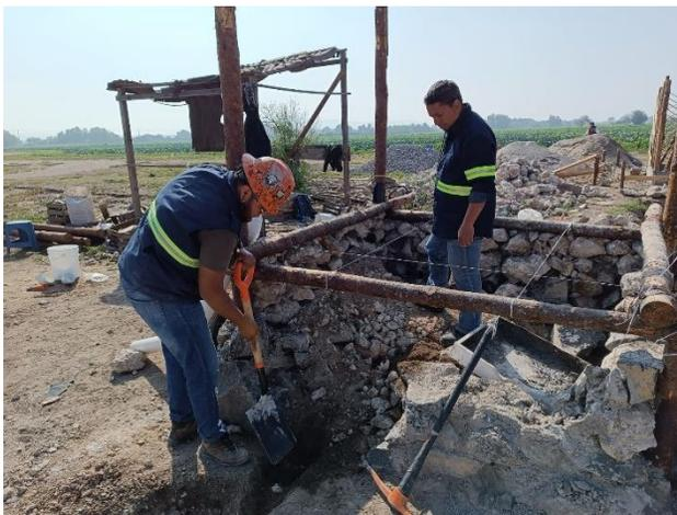
Imagen 40. Colocación de morillo vertical. Fuente: Elaboración propia.
