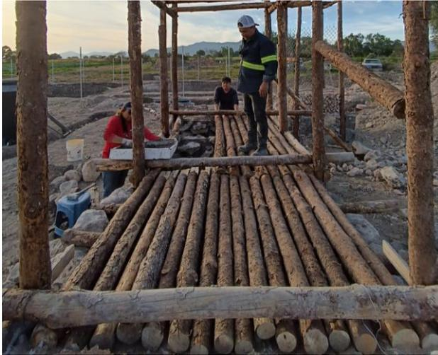
Imagen 42: Elaboración de piso para módulo de baño seco y letrina. Fuente: Elaboración propia.
